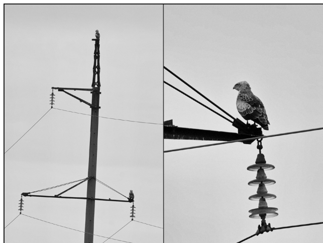
Фото 2. Зимующие змееяды на опоре ЛЭП. 4.02.2013 г. Photo 2. Wintering Short-toed Eagles on a pole of power line.
