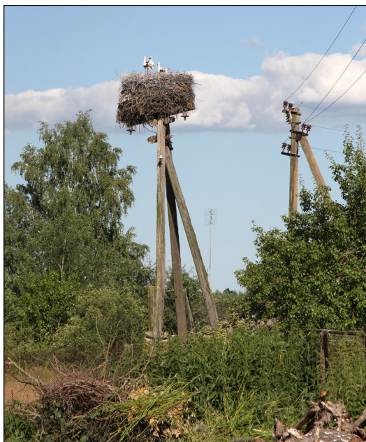
Прокладаючи нову електролінію, старого стовпа залишили лелекам, с. Станіславчик Черкаської області, 19.06.2014 р.
