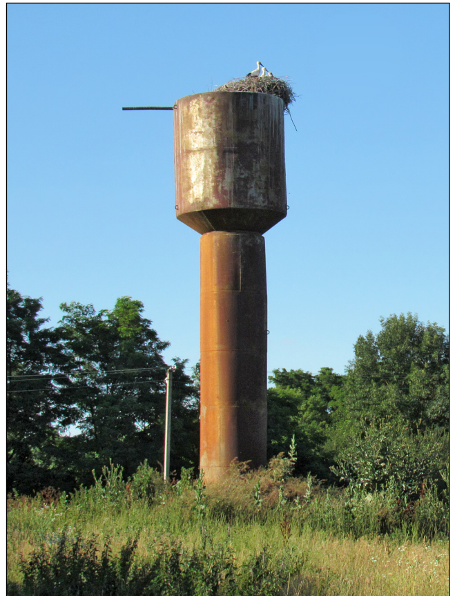
Фото 6. Лелечих гнізд на водонапірних баштах стає все менше, с. Безпальче Золотоніського району. 26.06.2024 р.
